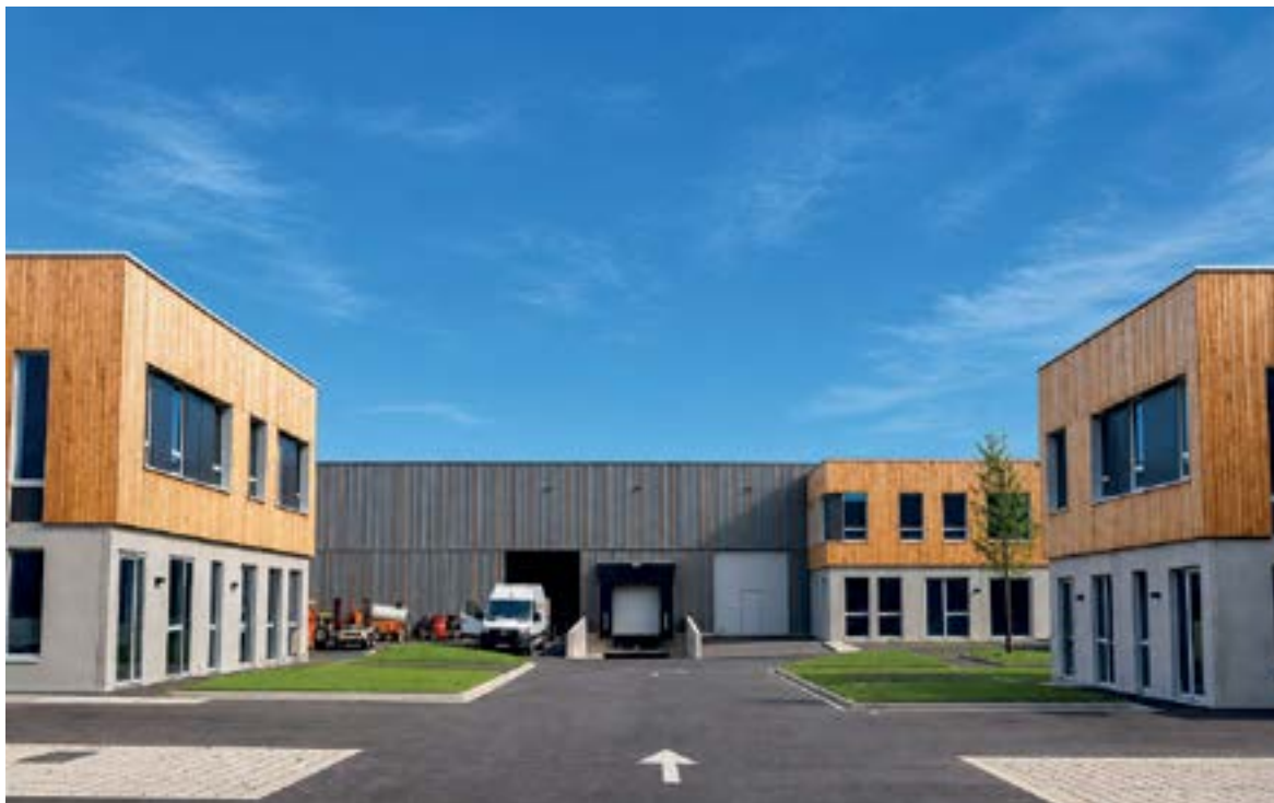
Cet été à Fretin, Boreas a réalisé pour Nord Invest 1 l'acquisition d'un bâtiment d'activité neuf de 1000 m 2 loué à un groupe national avec un bail ferme de 9 ans.
