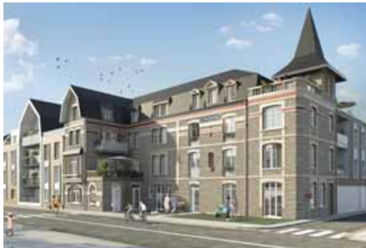
Vinci Immobilier réhabilite une partie du bâtiment principal et réalise une extension pour donner naissance à la résidence Reflets d'Ecume à Berck-sur-Mer.
