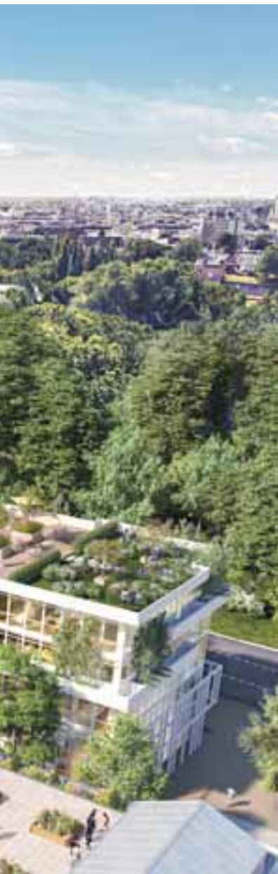
Ci-dessus, le programme mixte Sensorium situé à la lisière du quartier Euralille et de La Madeleine. Dès 2024, il offrira 18 000 m 2 de bureaux et 135 appartements. Un chantier mené par Eiffage Construction et réalisé en copromotion par Bouygues Immobilier et Sogeprom-Projectim.
